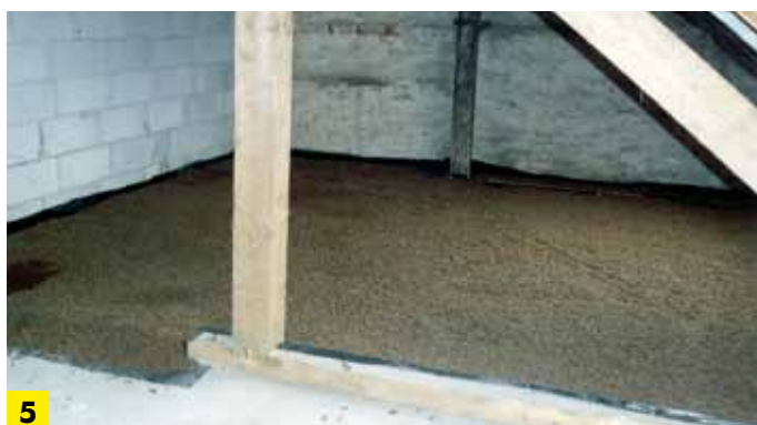
Izolacja na stropie poddasza
