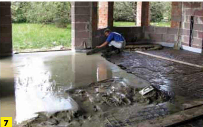
Wykonanie szlichty betonowej
