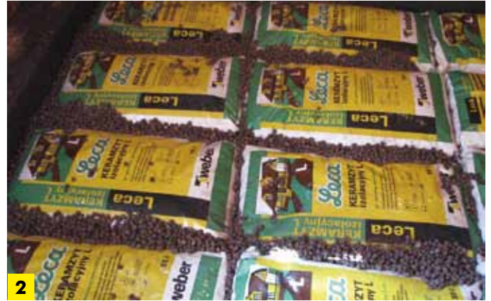
2 Zасыpywanie szczelin pomiędzy workami
