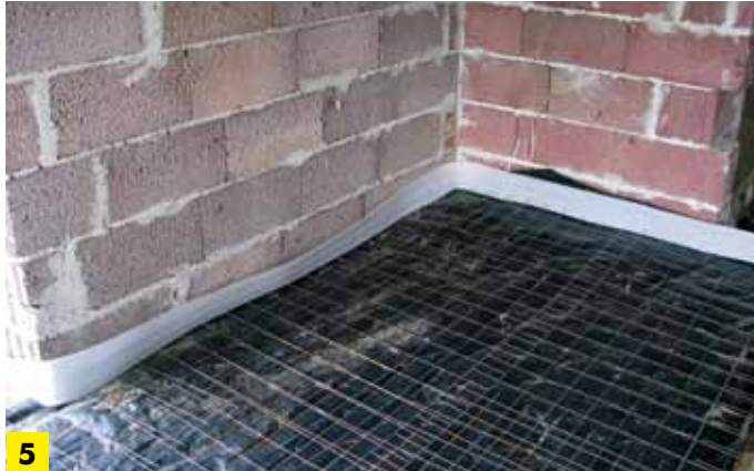
5 Układanie siatki i dylatacji obwodowej
