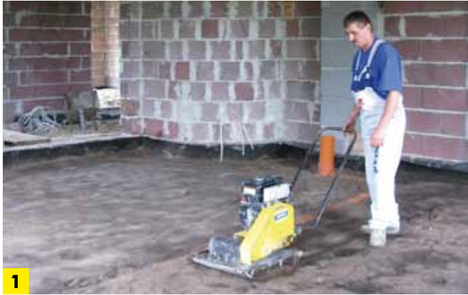
Zagęszczanie podłoża
