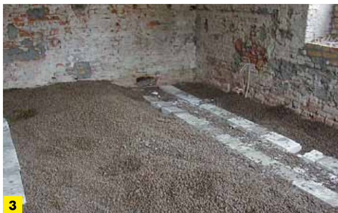
1 Stare wypełnienie na sklepieniach - piasek
