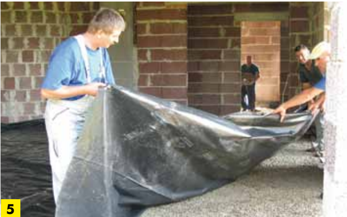
Układanie izolacji z folii
