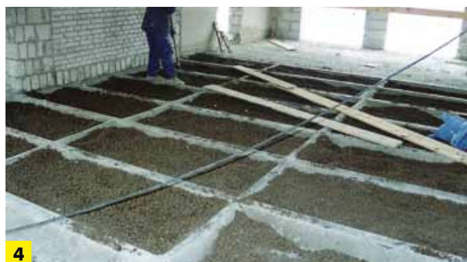
Wypełnienie stropu z krzyżującymi się żebrami
