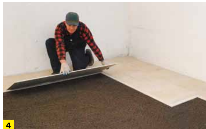
Układanie płyt suchego jastrychu
