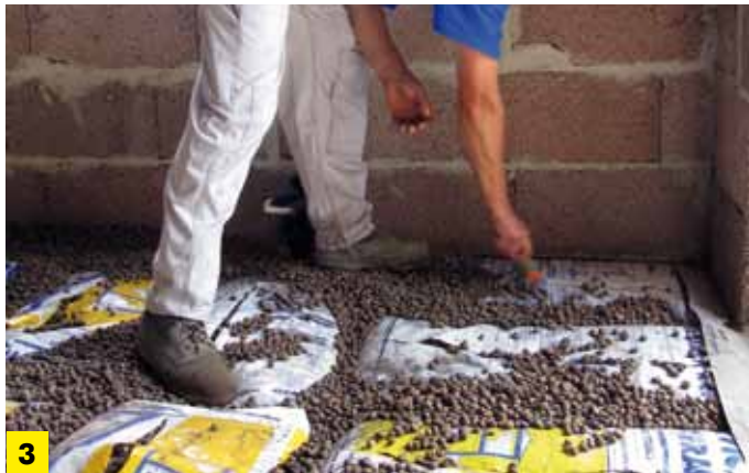
3 Przycinanie i odpowietrzanie worków
