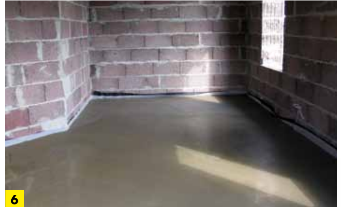
6 Gotowe podłoże na workach z Leca® KERAMZYTEM
