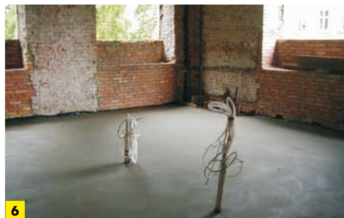
4 Wyrównane podłoże
