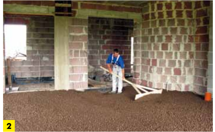
Układanie Leca® KERAMZYTU
