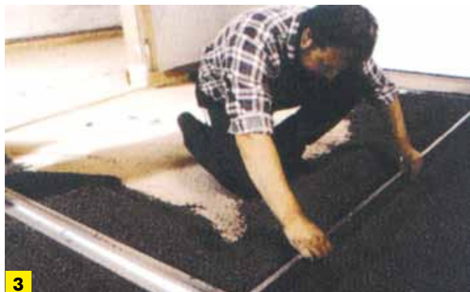
Układanie Leca® KERAMZYTU pod suchy jastrych
