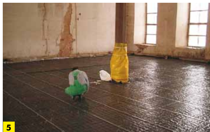
3 Układanie Leca® KERAMZYTU
