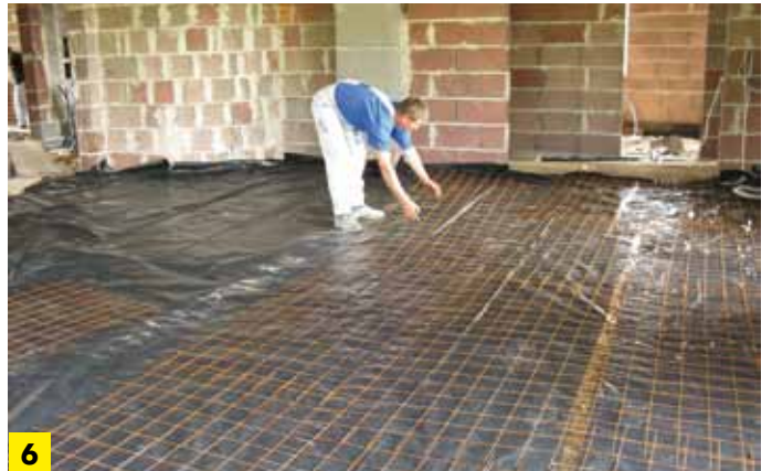
Układanie siatki zbrojenia
