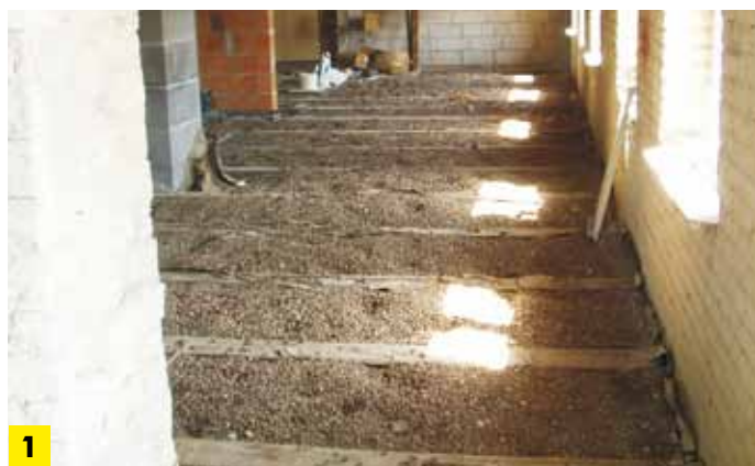
Układanie Leca® KERAMZYTU w stropie
