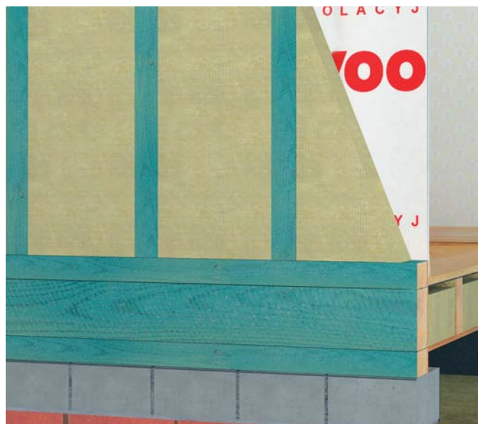
WIZ. 122.2. Ułożenie pierwszej warstwy wełny między słupkami drewnianymi.
